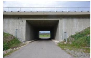
**Mögliche Optimierungsmaßnahmen:** Der Durchlass besteht aus einem engen Betonprofil, der Boden ist lückenlos geteert. Keine Optimierungsmöglichkeit – mit vertretbarem Aufwand ist hier sicher keine Verbesserung zu erzielen.
